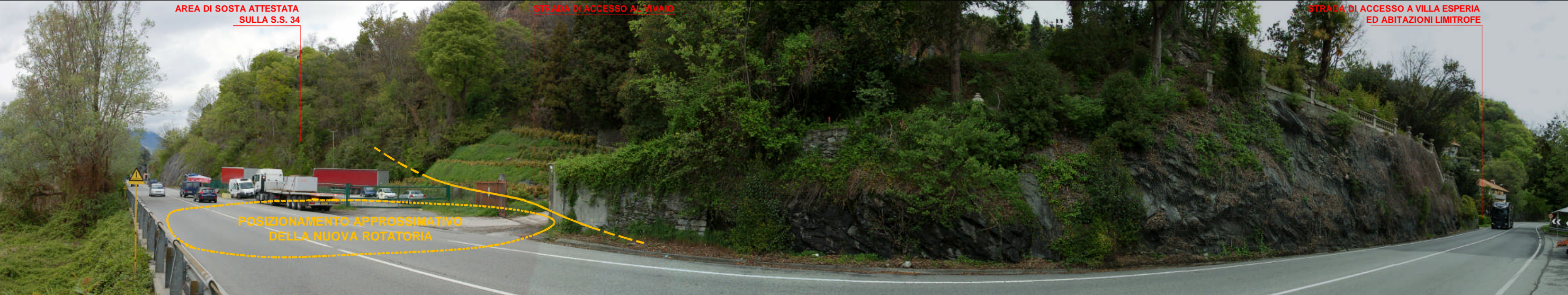
FOTO 2.8 - VISTA DELL'AREA DESTINATA AD ACCOGLIERE LA ROTATORIA DELLA VARIANTE ALLA S.S. 34 E LE OPERE AD ESSA CONNESSE: LA ZONA RECINTATA UTILIZZATA COME PARCHEGGIO PRIVATO ACCOGLIERA' L'AREA DI TRIAGE; LA STRADA DI ACCESSO AL VIVAIO, INTERFERENDO CON LA NUOVA ROTATORIA, SARA' RIPRISTINATA AD EST IMMETTENDOLA SULLA STRADA DI INGRESSO A VILLA ESPERIA
